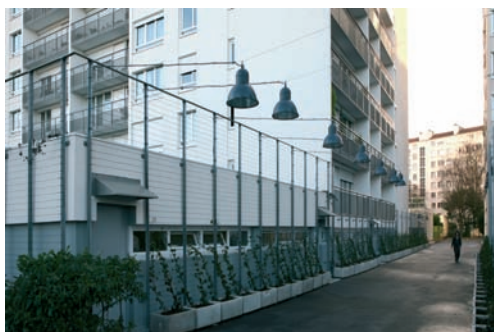
DES ALLÉES VÉGÉTALISÉES POUR FACILITER LA CIRCULATION PIÉTONNE DANS LA RÉSIDENCE
